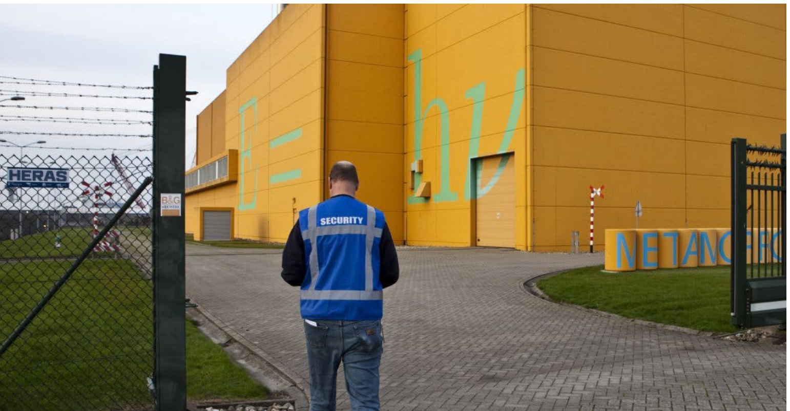
Foto: het COVRA-gebouw in Nieuwdorp - Evelyne Jacq ANP
