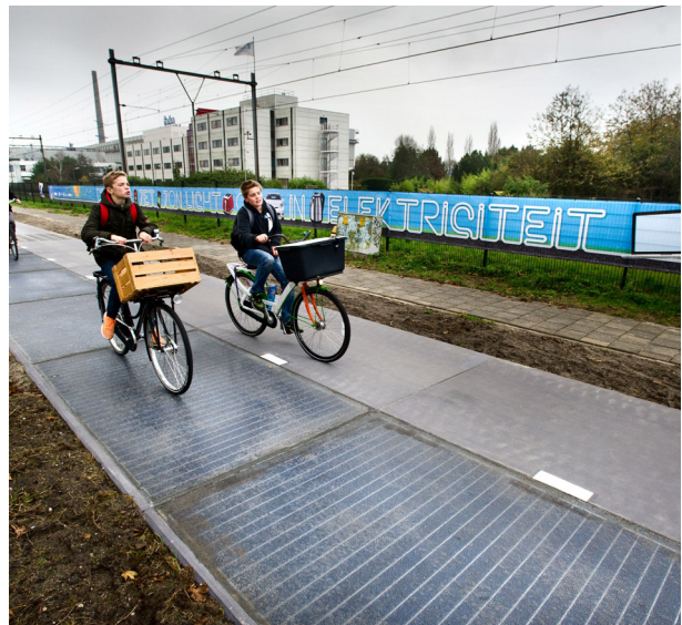
Fietspad met zonnepanelen in Krommenie.
